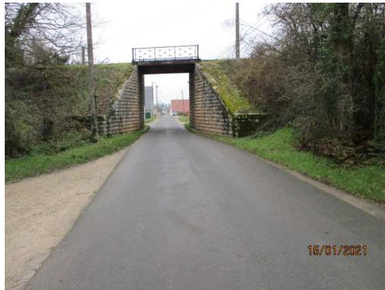
Lors de l'inondation de juin 2016, l'ouvrage hydraulique SNCF a laissé transiter le débit produit par le ruissellement de surface. (Nota l'ouvrage avait une section hydraulique réduite par les dépôts déjà sédimenté au fond son débit capable n'était alors pas égale à 1.452 m<sup>3</sup>/s)
